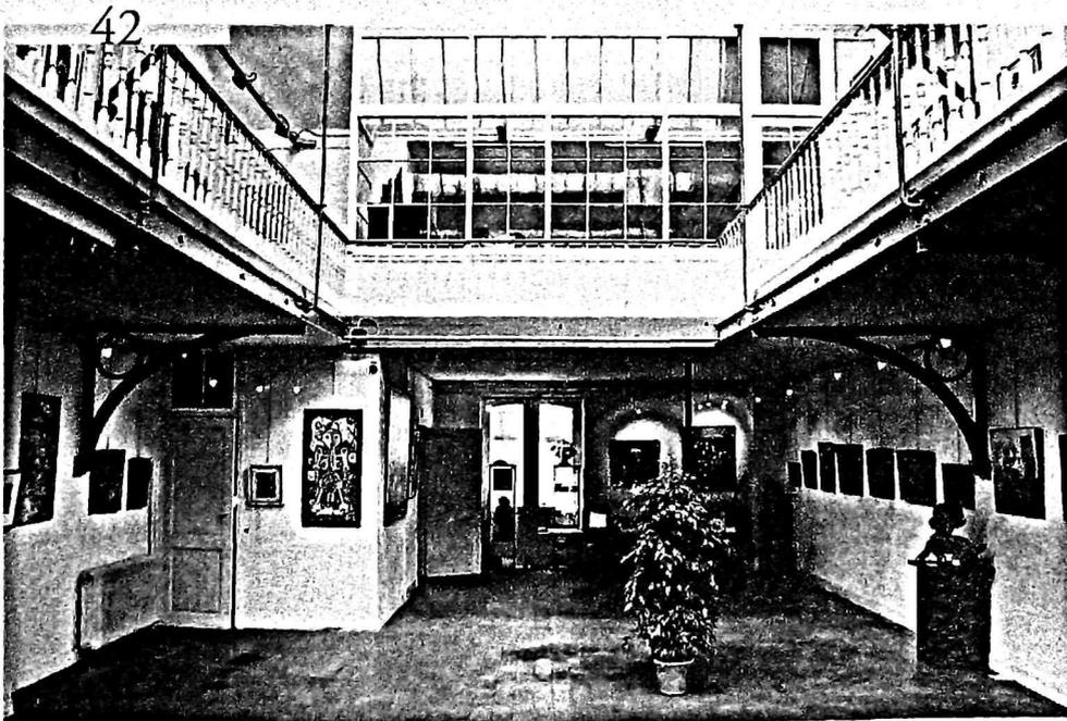
Conçus de manière traditionnelle autour d'une cour intérieure, les bâtiments de la raffinerie présentent une structure interne de poutrelles et colonnes de fonte portant des planchers en béton. Le bâtiment principal comporte une belle charpente métallique.
