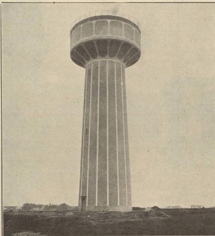
FIG. 3. — RÉSERVOIR D'ONNAING. — Cuve de 600 m<sup>3</sup> sur tour de 32 m.
